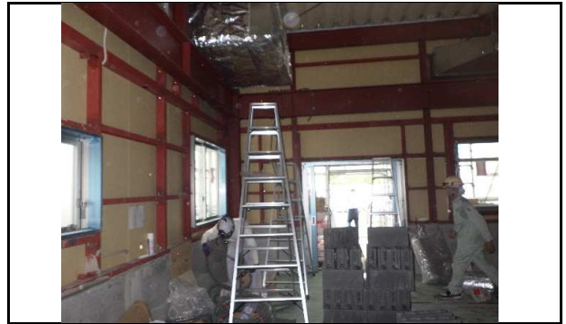
高所作業時の脚立の使用確認
