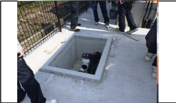
①井戸配管ピット開口部の落下対策不足
